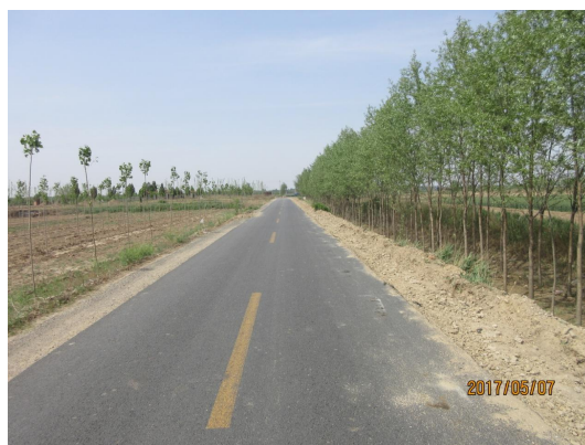
图 3-31 苑各庄村道碎石化养护工程现场照片
