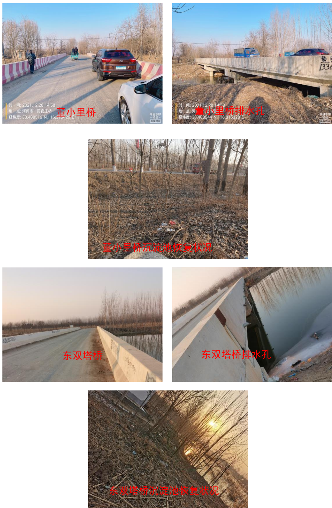
图 3-39 四座农村公路危桥改造工程完工现场照片
