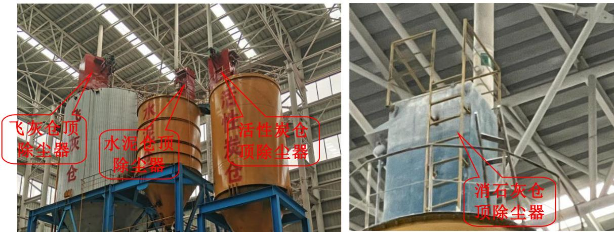
图 4-4 料仓有组织废气环保设施概貌
