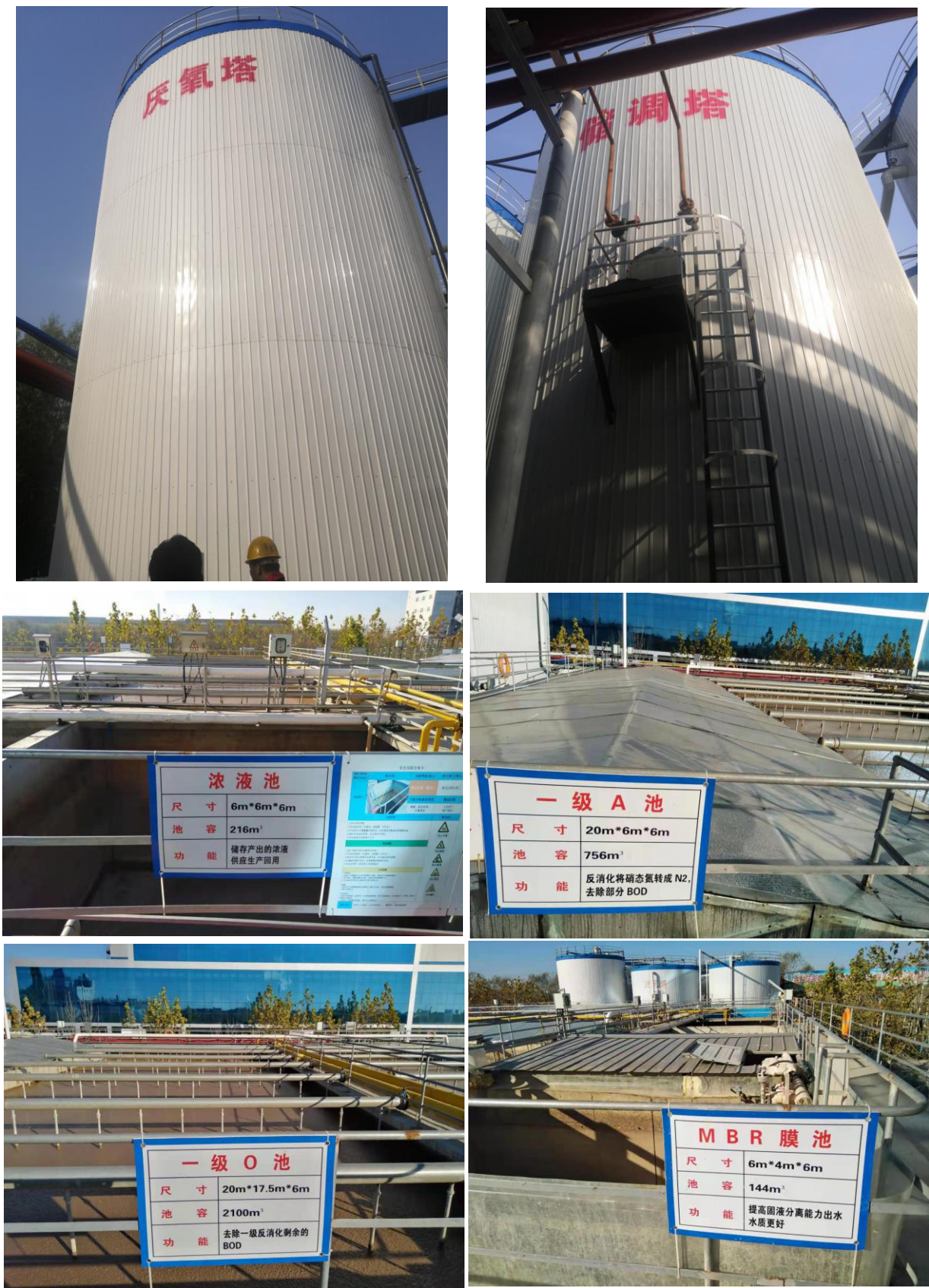
图 3-11 渗滤液处理站概貌照片
