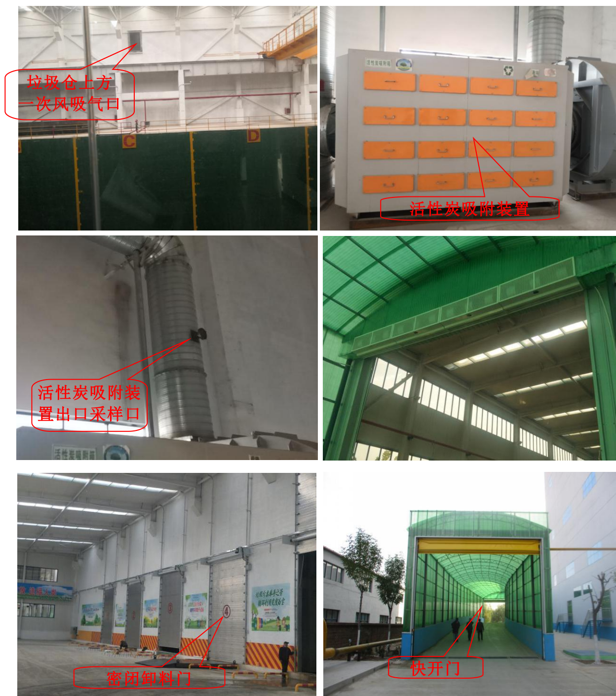
图 4-1 垃圾仓臭气环保设施概貌
